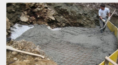
Herstellung der Abdeckplatte
