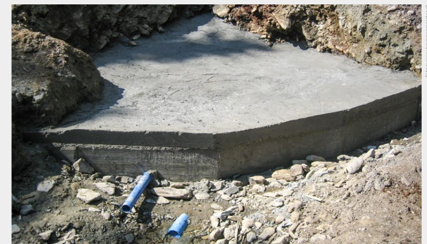
Fertige Abdeckplatte und Fangmauer
