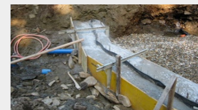
Bau einer Fangmauer
